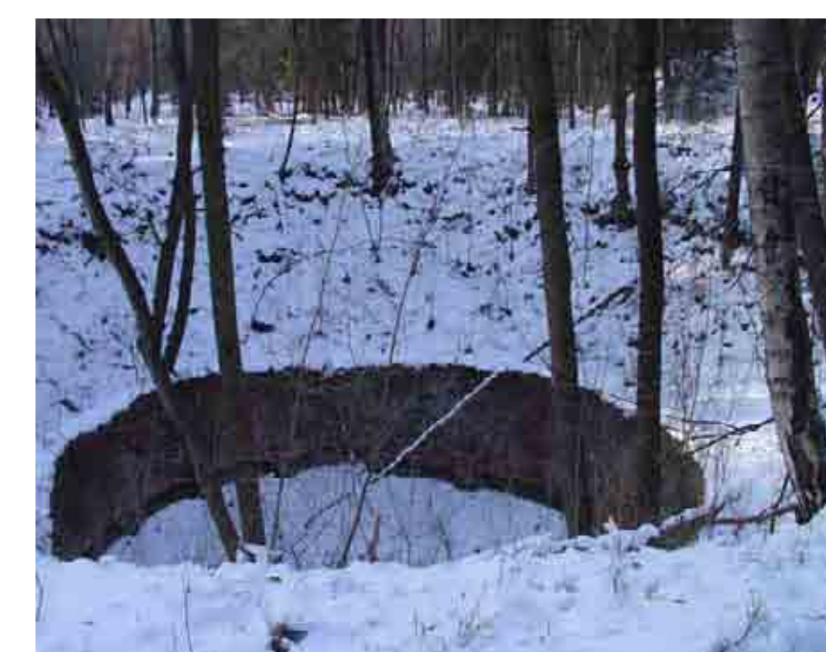
Ein Schachtbrunnen von 10m Durchmesser stellte Wasser zum Kühlen des Nitrierprozesses und zum Fluten eines Umgebungsgrabens zur Verfügung, um das Übergreifen eines Waldbrandes auf die Fabrik zu verhindern
